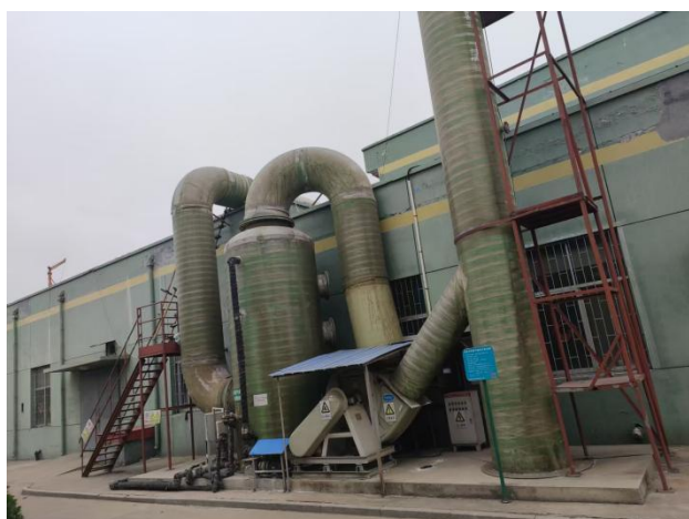
准备车间水喷淋+碱喷淋装置
