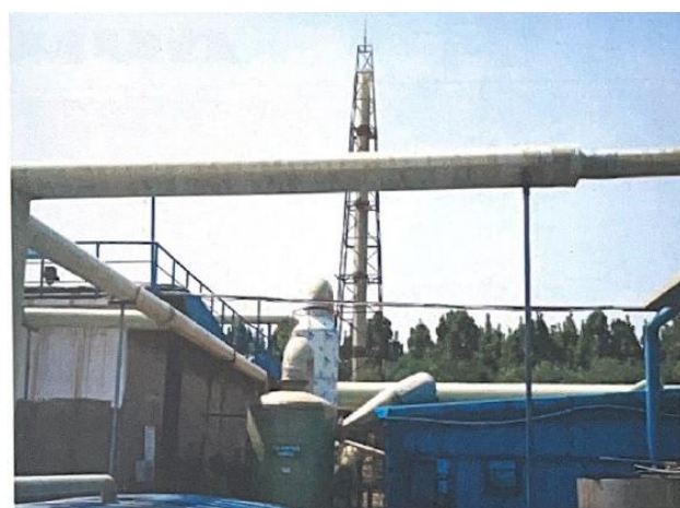
污水处理站鼓泡塔+喷淋塔+活性炭吸附装置 及其 DA003 排气筒
