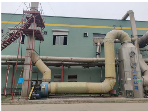
整理车间水喷淋+碱喷淋装置
